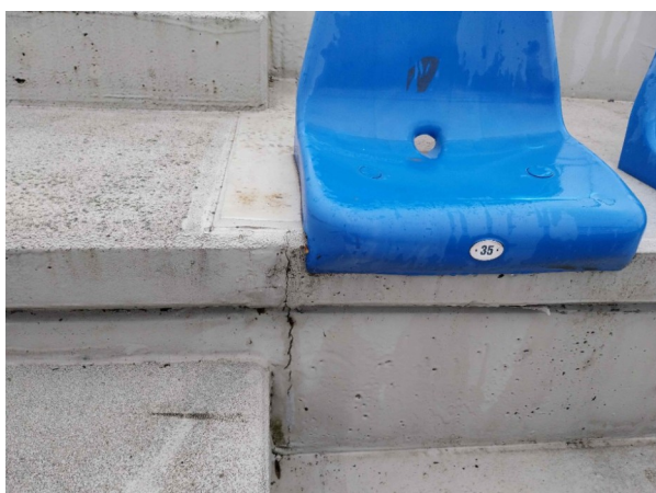
Foto /25/ Porušená dilatační spára
