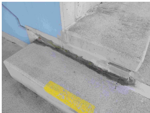
Foto /28/ Porušená dilatační spára
