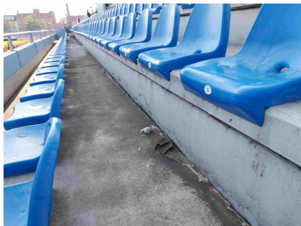
Foto /21/ Loupající se nátěr na vodorovných plochách Foto /22/ Loupající se nátěr na vodorovných plochách
