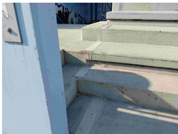
Foto /32/ Porušená dilatační spára
