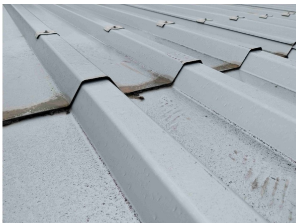
Foto /10/ Podélný spoj tabulí trapézového plechu
