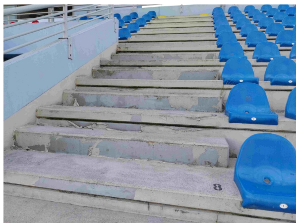
Foto /16/ Loupající se nátěr na svislých plochách
