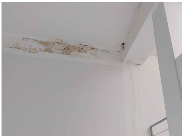
Foto /13/ Poškozený sádrokartonový podhled a obklad ocelových prvků střechy
