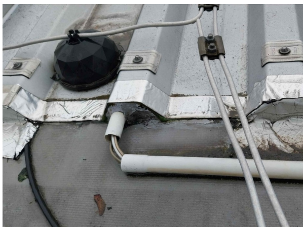
Foto /7/ Ukončení trapézového plechu u okapu
