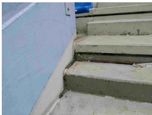
Foto /30/ Porušená dilatační spára
