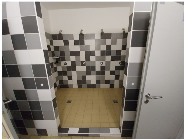
Foto /4/ Pohled na sprchový kout, ve kterém se odstraní keramický obklad a dlažba na podlaze, vč. Vpusť a vše se provede nově
