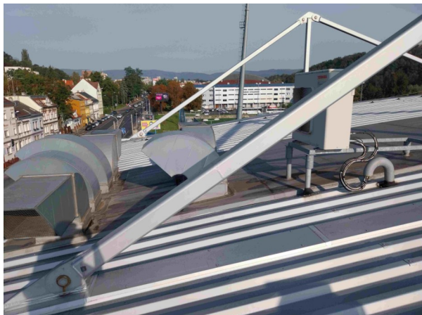
Foto /11/ Prostupy VZT potrubí, uchycení klimajednotky a kruhové prostupy
