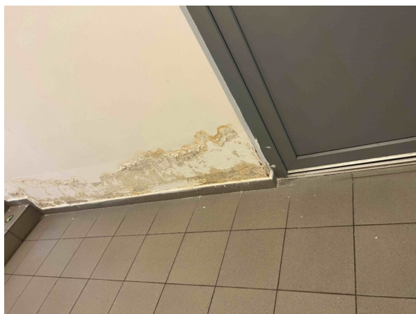
Foto /1/ Vlhkostní poruchy na vnitřní příčce sousedící s regenerací
