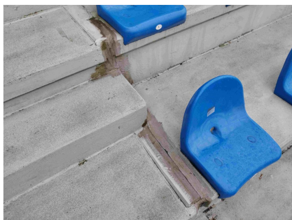
Foto /26/ Porušená dilatační spára
