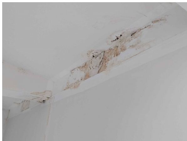
Foto /14/ Poškozený sádrokartonový podhled a obklad ocelových prvků střechy
