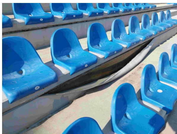
Foto /18/ Loupající se nátěr na svislých plochách
