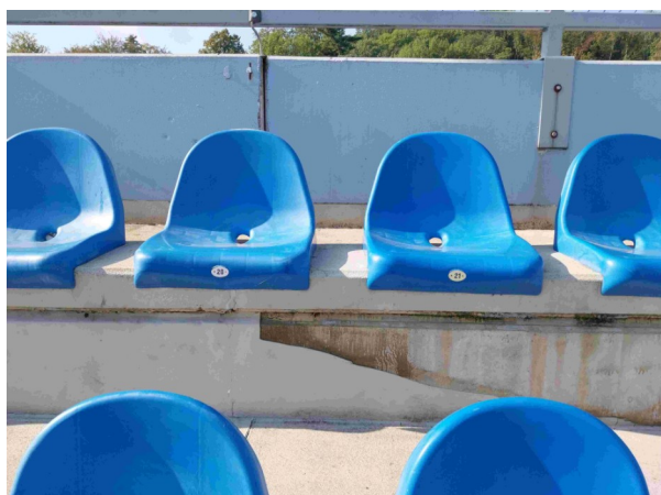
Foto /19/ Loupající se nátěr na svislých plochách
