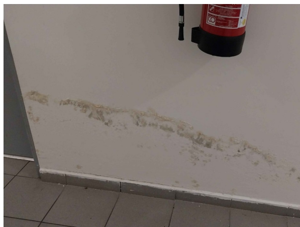
Foto /2/ Vlhkostní poruchy na vnitřní příčce sousedící s šatnou
