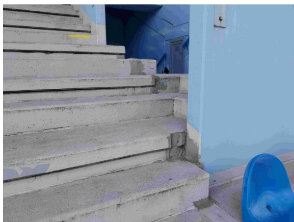
Foto /29/ Porušená dilatační spára
